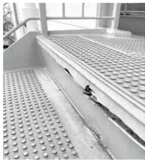
鉄骨階段：蹴上の長尺シートとウレタン塗装の劣化で鉄が錆びフレック状態で危険
